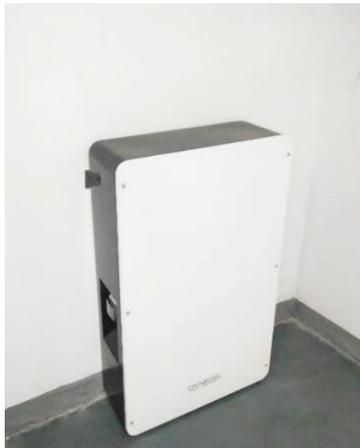
8. Leve a caixa da bateria para o ponto de montagem, colocá-lo cerca de 15 milímetros fora da parede, e afixar a orelha de gancho com a parte superior da caixa da bateria por parafuso M6
