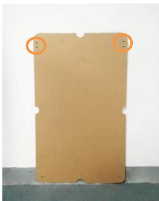
1. Desenhe a posição de abertura do parafuso na parede com a placa de posicionamento correspondente, como as quatro posições de buraco à esquerda.
