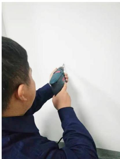
4. Marque a posição por broca elétrica, abrir 8 buracos de diâmetro de 10 mm na parede, a profundidade do buraco precisa ser maior do que 70 milímetros, para os parafusos de expansão M6.
