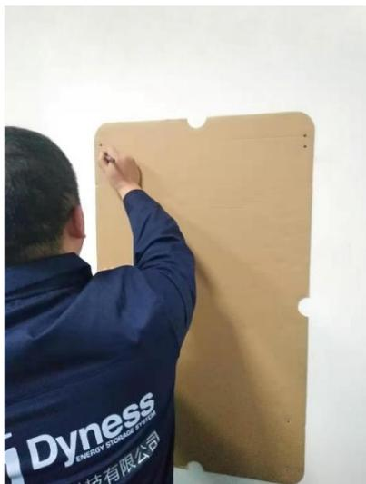
1. Marque a posição de abertura do parafuso na parede com a placa de posicionamento, como a imagem esquerda.
