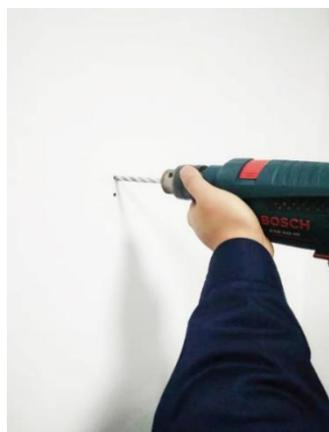
3. Marque a posição marcada por broca elétrica, abrir 4 buracos de diâmetro de 10 mm na parede, a profundidade do buraco precisa ser maior do que 70 milímetros, para os parafusos de expansão M6.
